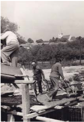
Stavebné práce v obci
