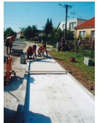
Výstavba nového chodníka
